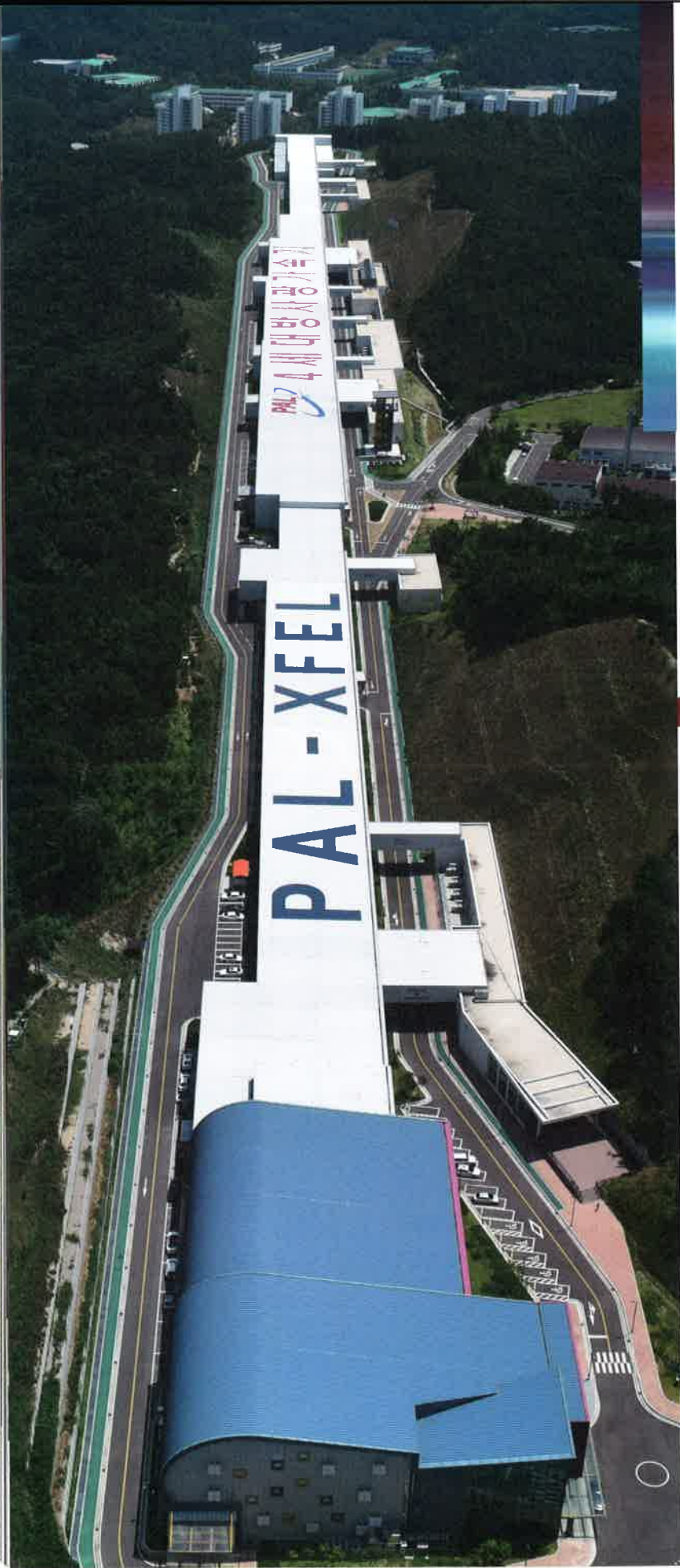
포항가속기연구소의 전경. 지붕에 'PAL-XFEL'이라고 표시된 건물에 4세대 방사광가속기가 들어 있다. 길이가 무려 1.1km에 이른다. 4세대 방사광가속기는 2015년 구축된 뒤 2017년부터 기초 및 응용과학 연구에 활용되고 있다.
