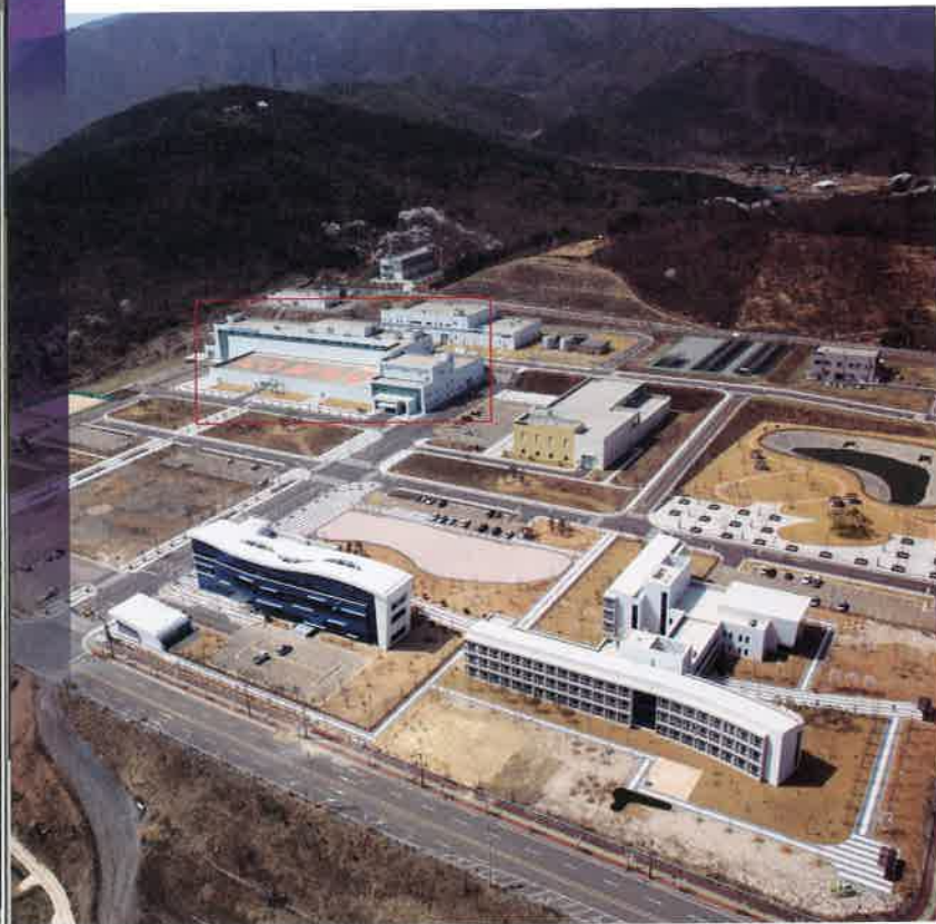
경주 양성자가속기연구센터전경. 사진에 빨간색네모로 표시된 건물이 '가속기삼형제'의말형 격인 양성자가속기가 설치된 가속기동이다.
